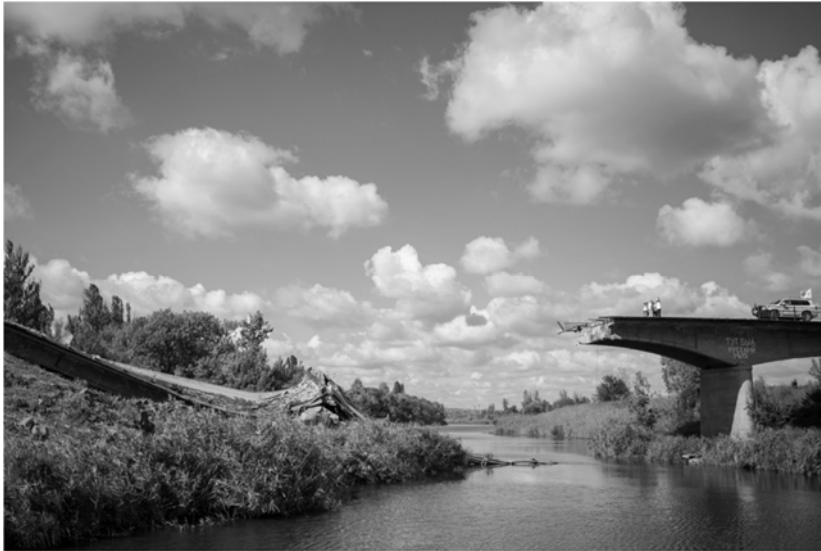
Abbildung 2: Ukraine, Zerstörte Brücke in Slowjansk (© Photothek)
